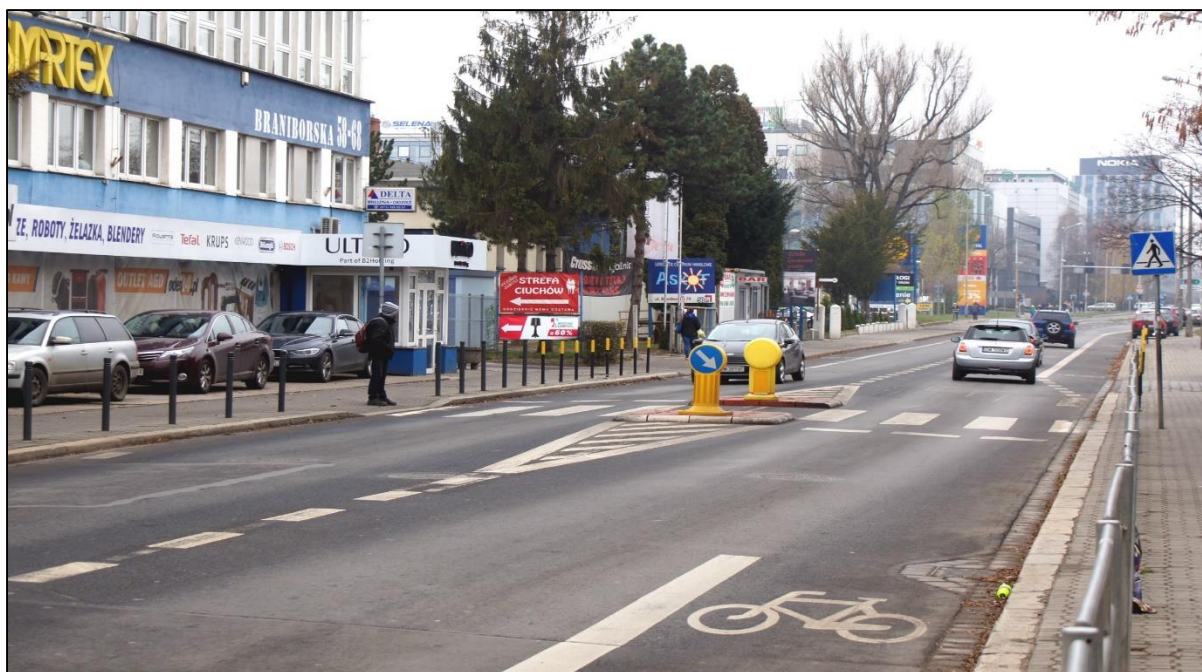
Rys. 3.3.3. Przykład zmniejszenia szerokości przekroju jezdni poprzez wydzielenie trasy rowerowej wraz z przejściem dla pieszych z zastosowaniem wyspy azyli oraz tzw. pylonów zespolonych ze znakiem C-9. Dodatkowo zastosowano odgięcie torów jazdy w celu dodatkowego spowolnienia ruchu pojazdów.
