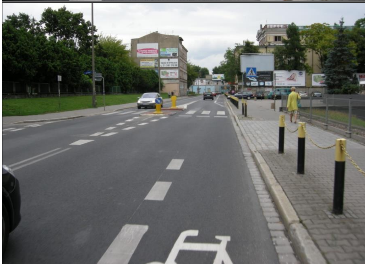
Rys. 3.5.4. Przykład wydzielenia pasa ruchu dla rowerów z szerokości pasa dla ruchu ogólnego (źródło własne).
