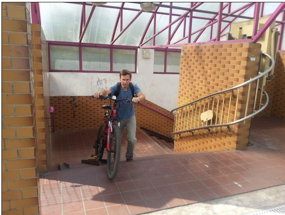
Rys. 2.4.5. Przejście podziemne pod DK94 nieprzystosowane do ruchu rowerowego (źródło własne).
