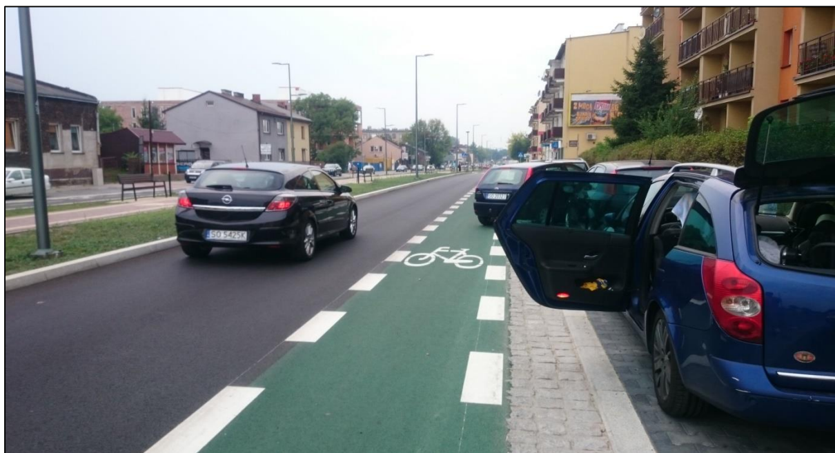
Rys. 3.5.5. Przykład zbiorczej trasy rowerowej w Dąbrowie Górniczej: Aleje Majakowskiego (źródło własne). Na zdjęciu przykład dobrej praktyki zachowania odpowiedniej odległości pasa rowerowego od parkingu, umożliwiającej bezkolizyjny przejazd rowerzysty obok pojazdu z otwartymi drzwiami.
