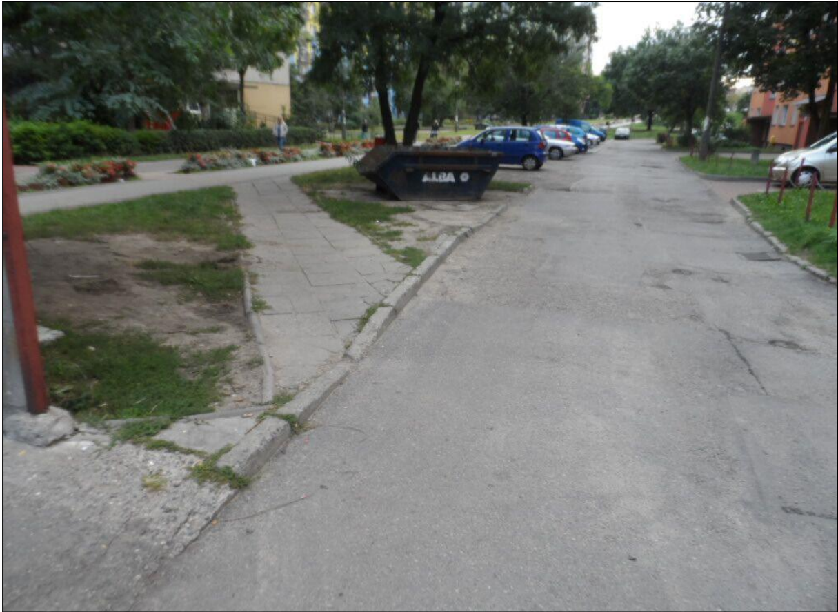
Rys. 2.4.2. Przykład potrzeby obniżenia krawężnika (źródło własne).
