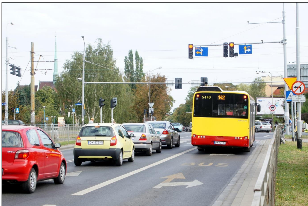
Rys. 3.4.3. Przykład dopuszczenia autobusów do jazdy na wprost z pasa służącego do skrętu w prawo oraz do skrętu w lewo z pasa służącego do jazdy na wprost (źródło własne).
