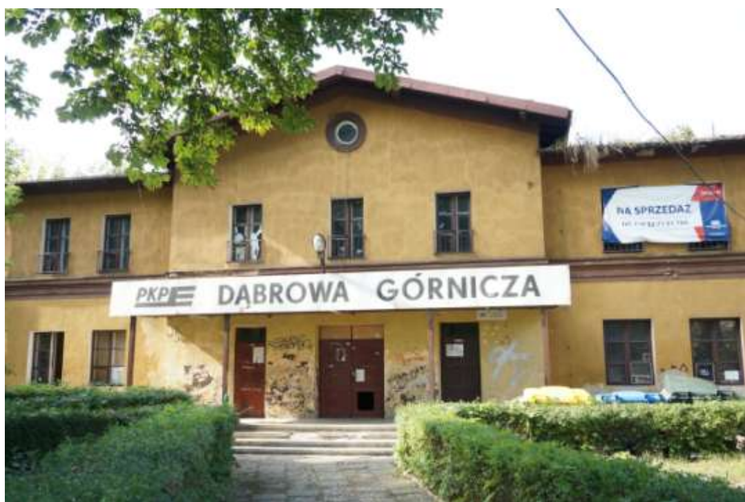
Zdjęcie 2. Nieczynny budynek dworca PKP Dąbrowa Górnicza (Autor: Adam Polko)
