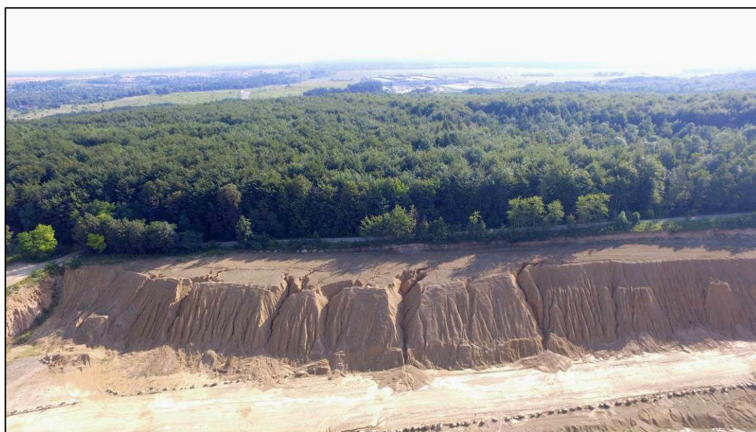
Fot.2. Zagospodarowanie obszaru opracowania. Widok z terenu istniejącej kopalni w stronę przedmiotowego terenu
