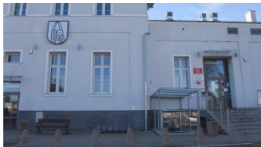
Wejście do MOPS na zmodernizowanym dworcu w Choszcznie
