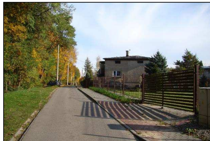
Fot. 4 Ul. Pszennej, centralna część obszaru objętego mpzp.
